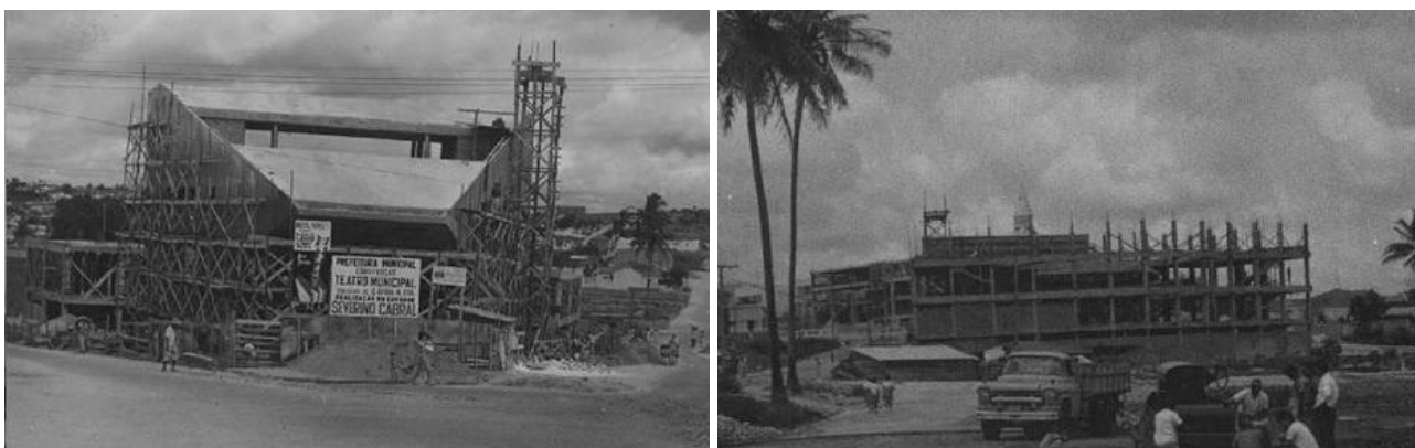
Figura 12: Imagens da construção do TMSC, possibilitando a visualização da estrutura de suporte
