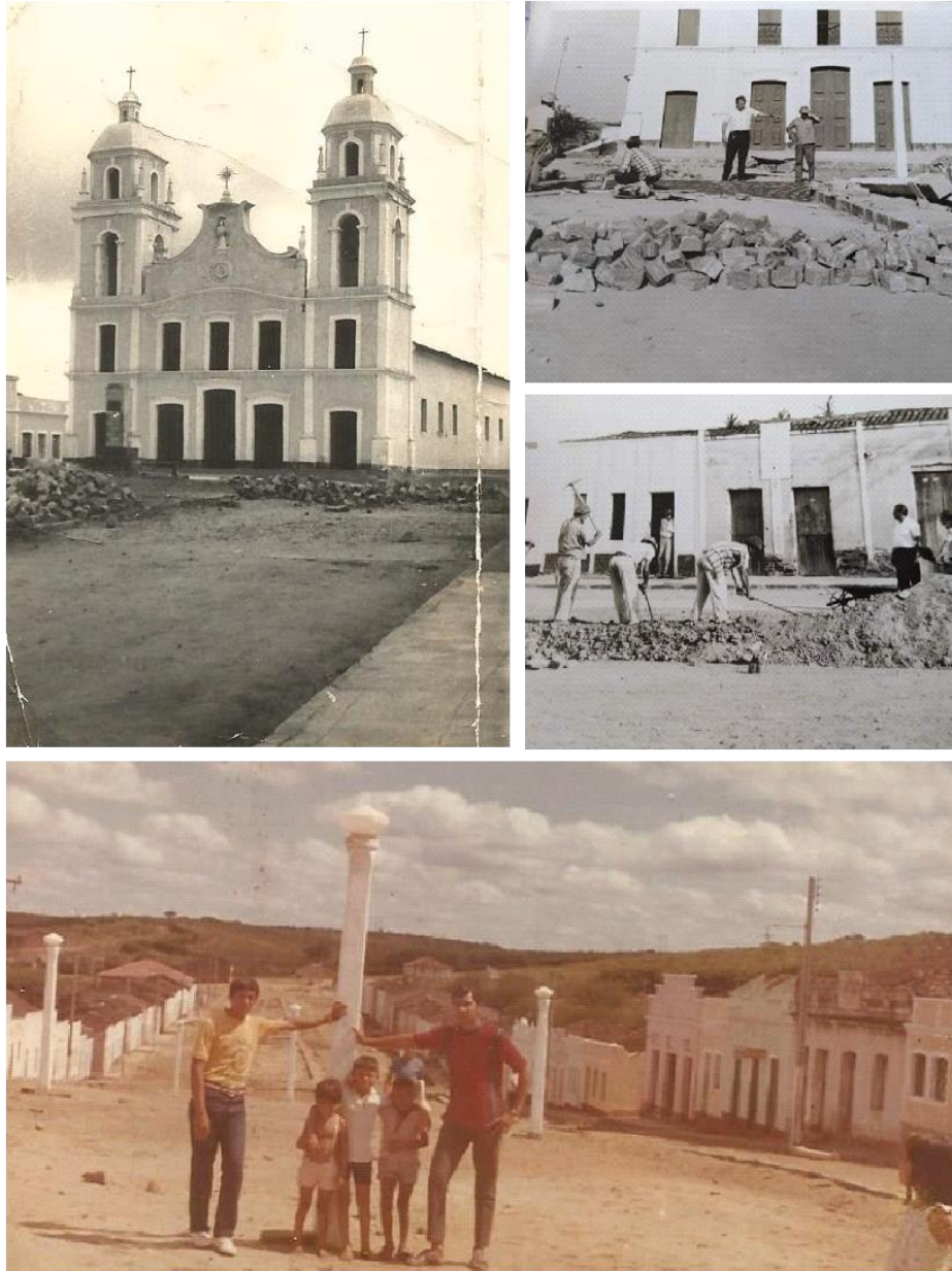
Figura 2: Pannel da construção do calçamento de Gravatá do Ibiapina e instalação dos primeiros postes públicos.
