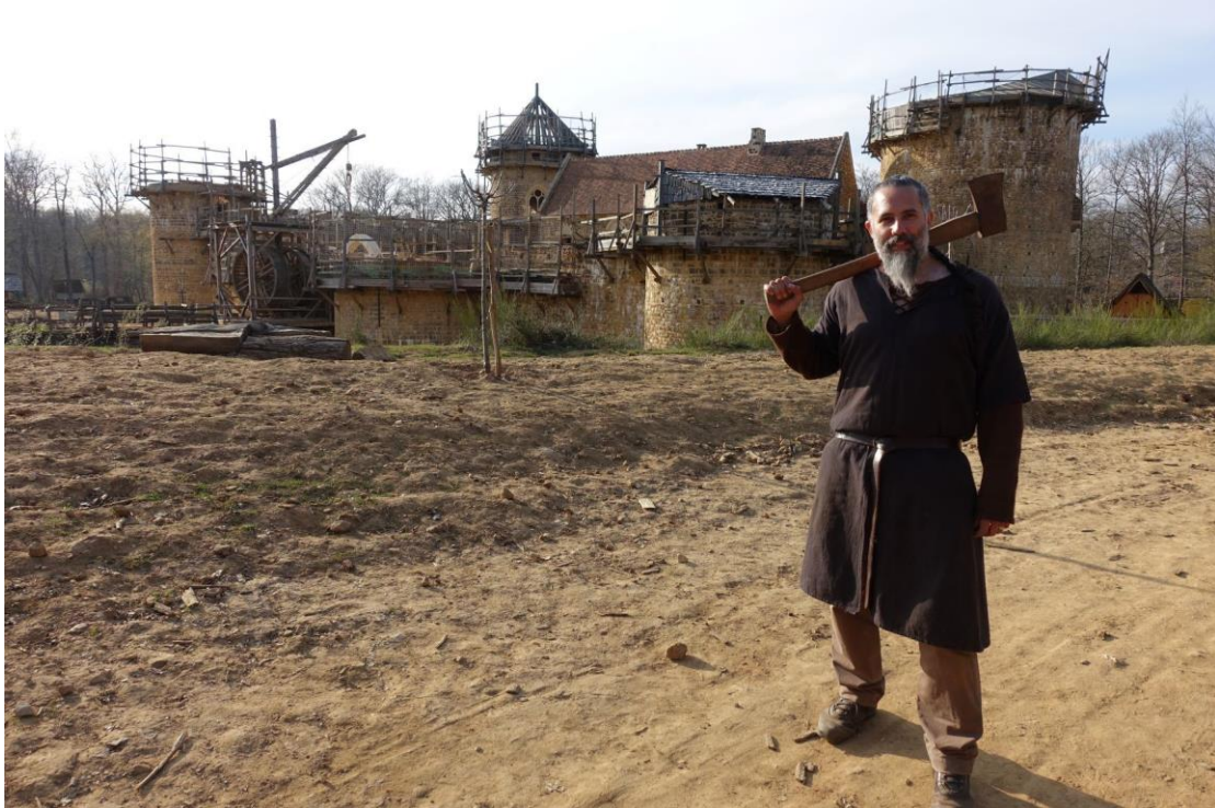
Figura 1: Construção do Castelo de Guédelon na França, depois de mais de duas décadas de obra, em 01 de março de 2019
