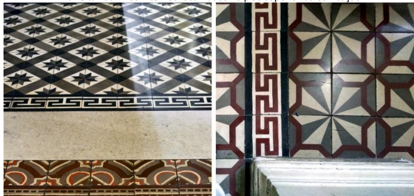
Figura 9: À esquerda: ladrilhos internos localizados nos corredores laterais do hall de entrada; À direita: ladrilhos internos localizados no piso superior da edificação.
