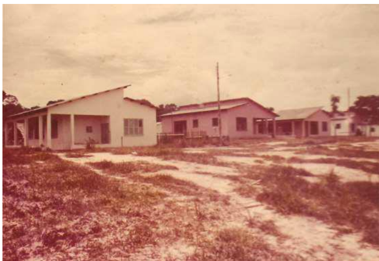
Figura 2: Vila Militar dos Cabos e Soldados em fase de construção, 1975 Fonte: Entrevistado.
