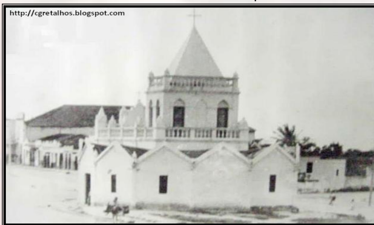
FOTOGRAFIA 06 - Imagem da Igreja da Guia no Bairro de São José
