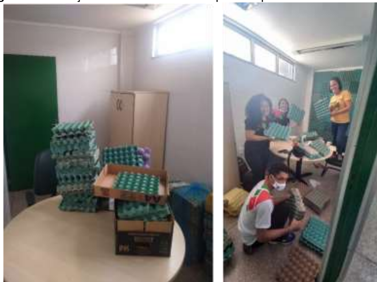
Figura 4 – Instalação das cubas de ovos nas paredes para isolamento acústico.
